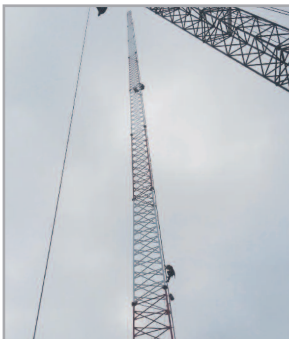
대정 해상풍력 기상탑 공사 (제주도)
