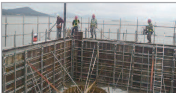
⑦ 벽체 콘크리트 타설
