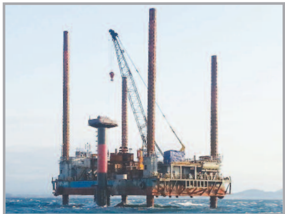
과부탄 등표 공사 (제주도)
