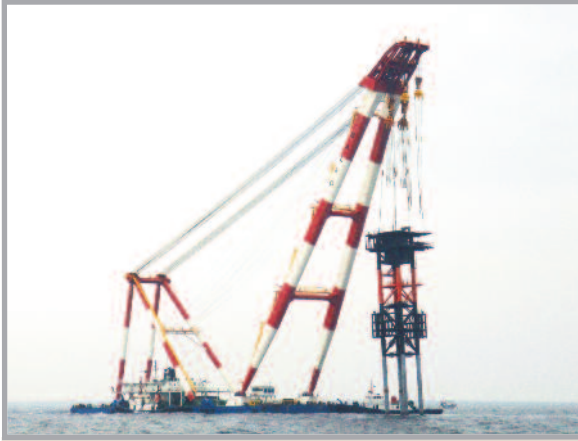
중뢰 등표 공사 (제주도)
