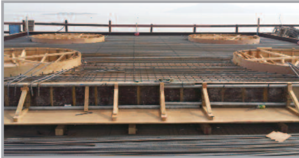
③ 기초 철근 배근
