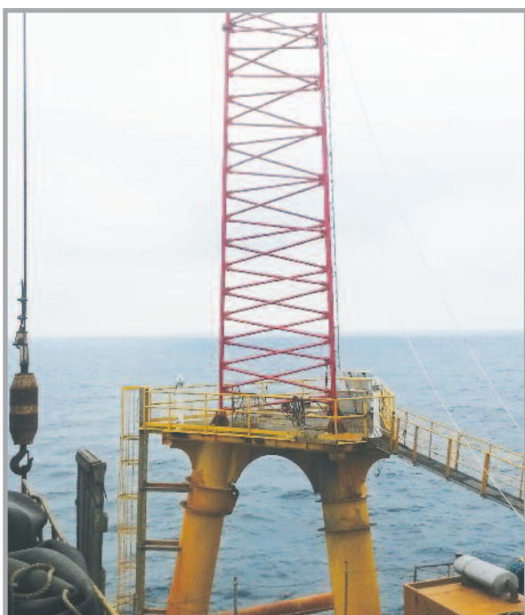
대정 해상풍력 기상탑 공사 (제주도)
