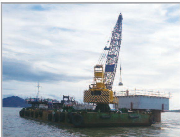
⑤ 확대기초 철근 조립
