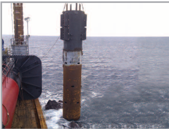
과부탄 등표 공사 (제주도)
