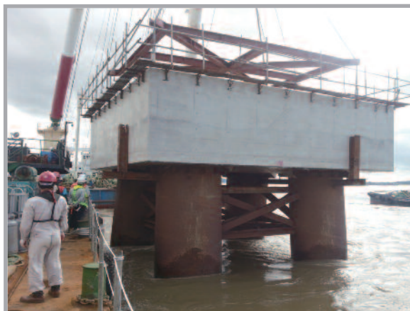
④ PC HOUSE 거치 완료
