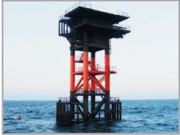
중뢰 등표 공사 (제주도)
