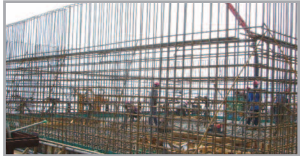
④ 기초 콘크리트 타설
