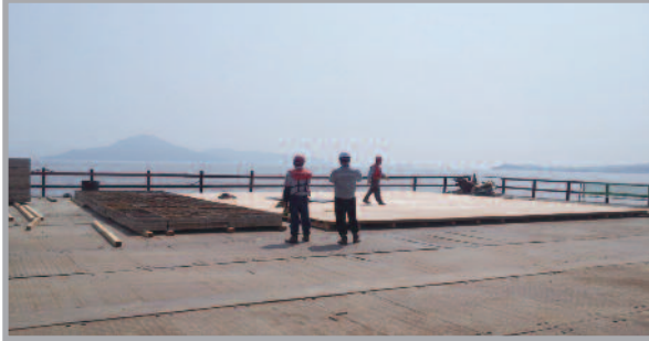
① 바닥 거푸집 설치
