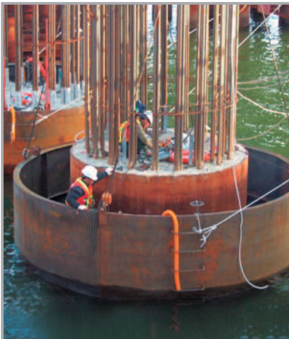
③ PILE BAND 설치
