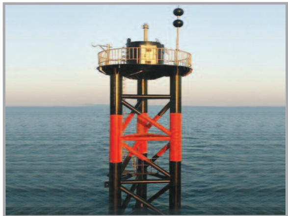
울도 북방등표 공사 (웅진군)
