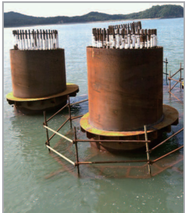
④ PILE BAND 설치 완료
