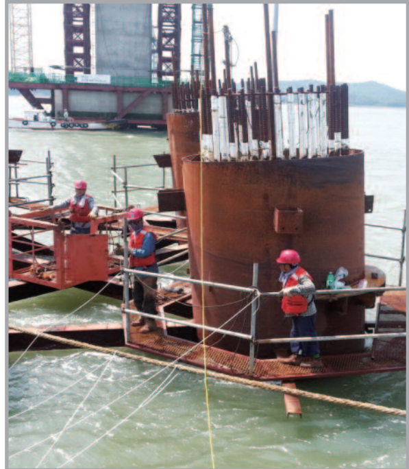
② 작업발판 설치
