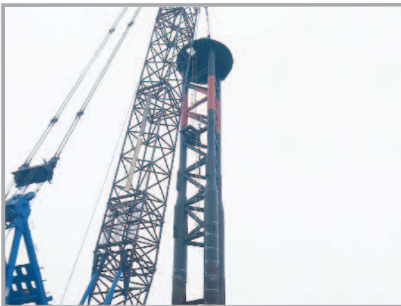
울도 북방등표 공사 (웅진군)
