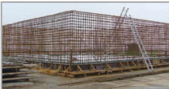
⑤ 기초 콘크리트 양생
