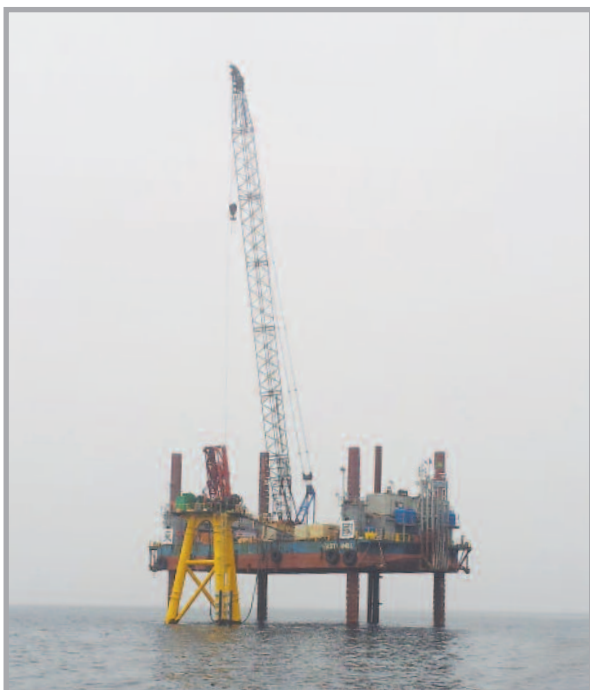
서남해 해상풍력 기상탑 공사 (신안군)
