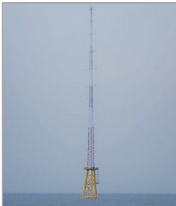
서남해 해상풍력 기상탑 공사 (신안군)
