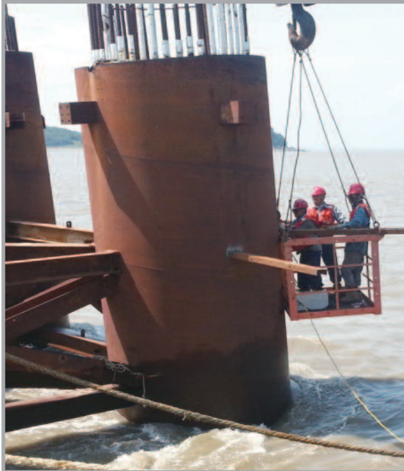
① 작업발판 설치 준비작업
